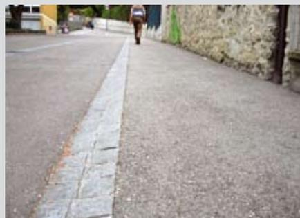
Une **bordure inclinée** en pavés (ou une bordure chanfreinée à hauteur basse de 4 cm) dont la couleur contraste avec le reste de la chaussée représente une solution adaptée au guidage des personnes aveugles ou malvoyantes.
